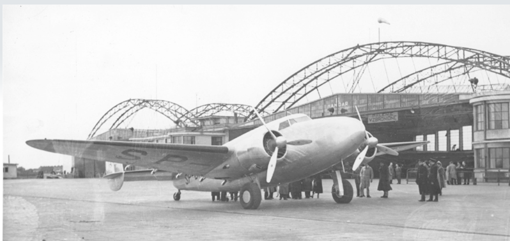
Samolot Lockheed L-14H Super Electra zabierał 12 pasażerów i miał zasięg 3100 km.
