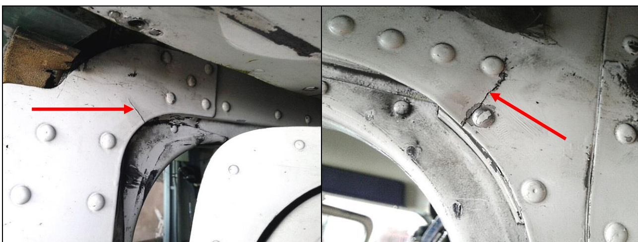
6, 7 – Pęknięcie kadłuba w wykroju drzwi – lewa strona – przód góra i tył góra.
