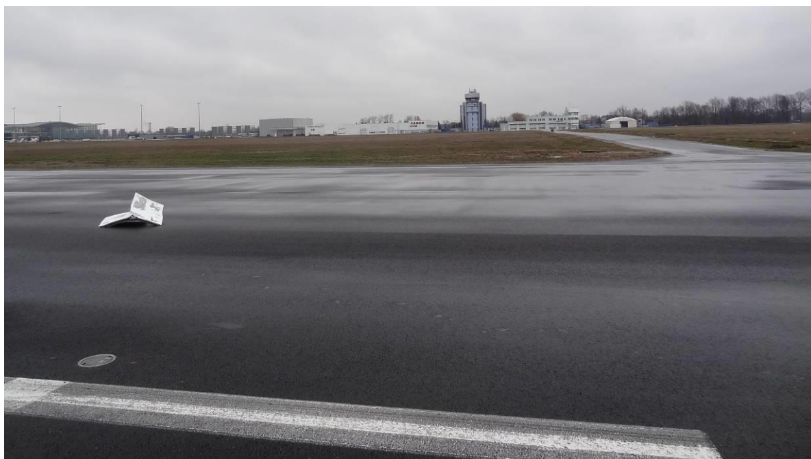
Rys. 1. Leżące na DS naprzeciwko wieży, wyrwane z gondoli, górne wewnętrzne drzwi prawego silnika.
