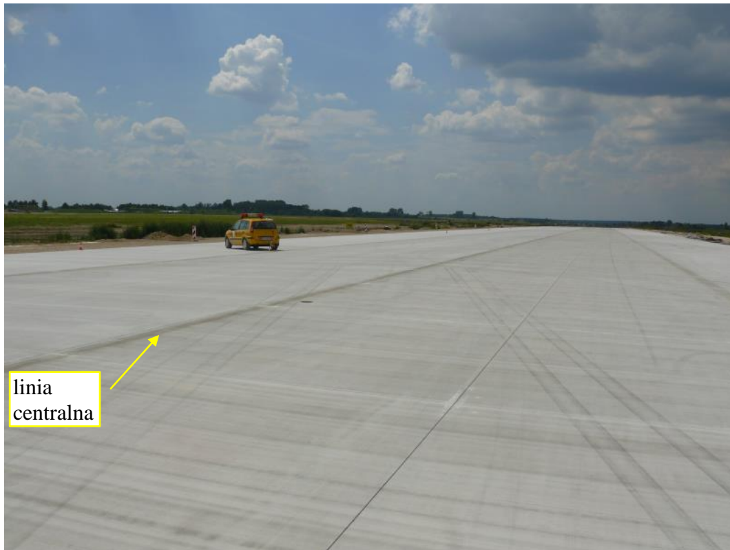
Fot. 12. Ślady zatrzymania samolotu na budowanej drodze startowej (~2700[m] od początku nawierzchni RWY 27).
