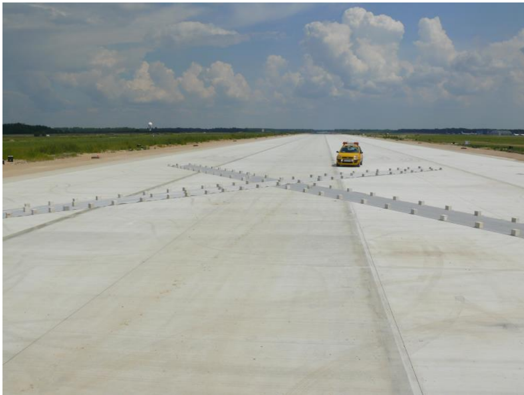
Fot. 4. Oznaczenie zamkniętej drogi startowej w budowie przy progu THR 09.
