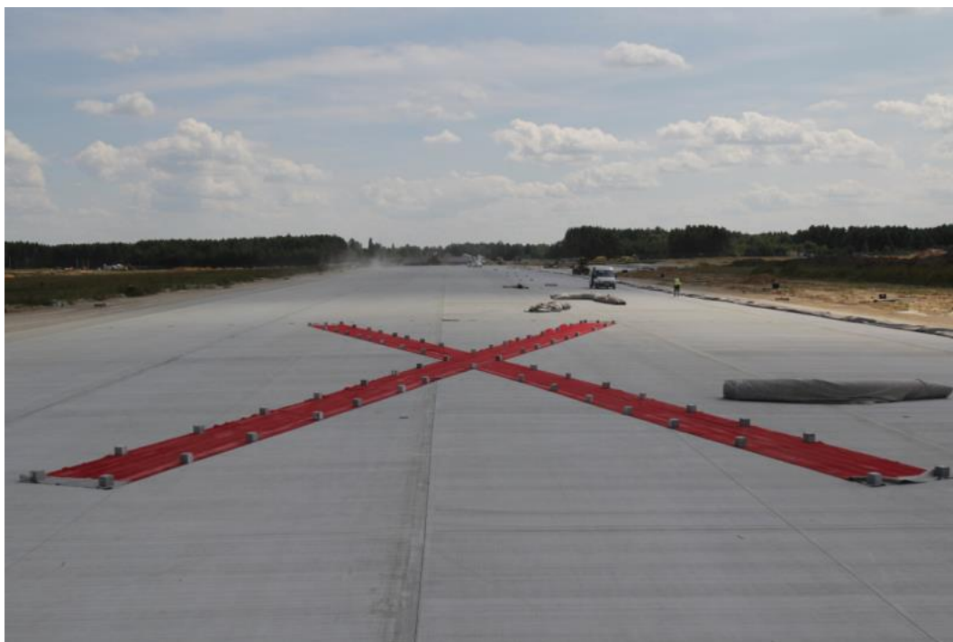
Fot. 15. Oznaczenie zamkniętej drogi startowej w budowie w rejonie progów THR 27.
