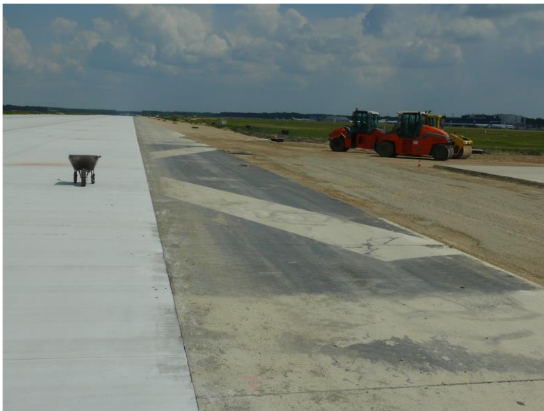
Fot. 5. Zabetonowane pozostałości oznakowania zamkniętej drogi startowej w budowie przy progu THR 09.
