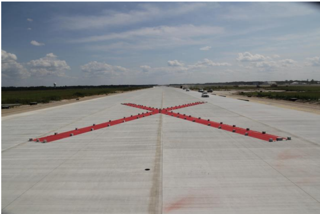
Fot. 16. Oznaczenie zamkniętej drogi startowej w budowie w rejonie progu THR 09.
