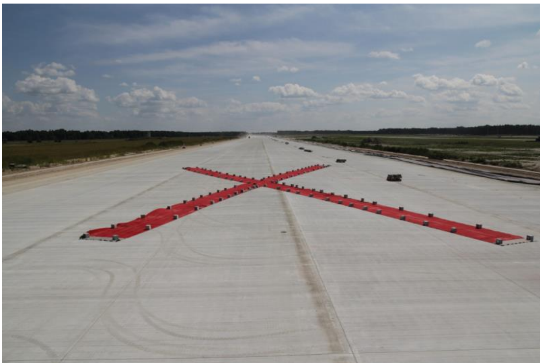
Fot. 17. Oznaczenie na środku zamkniętej drogi startowej w budowie.
