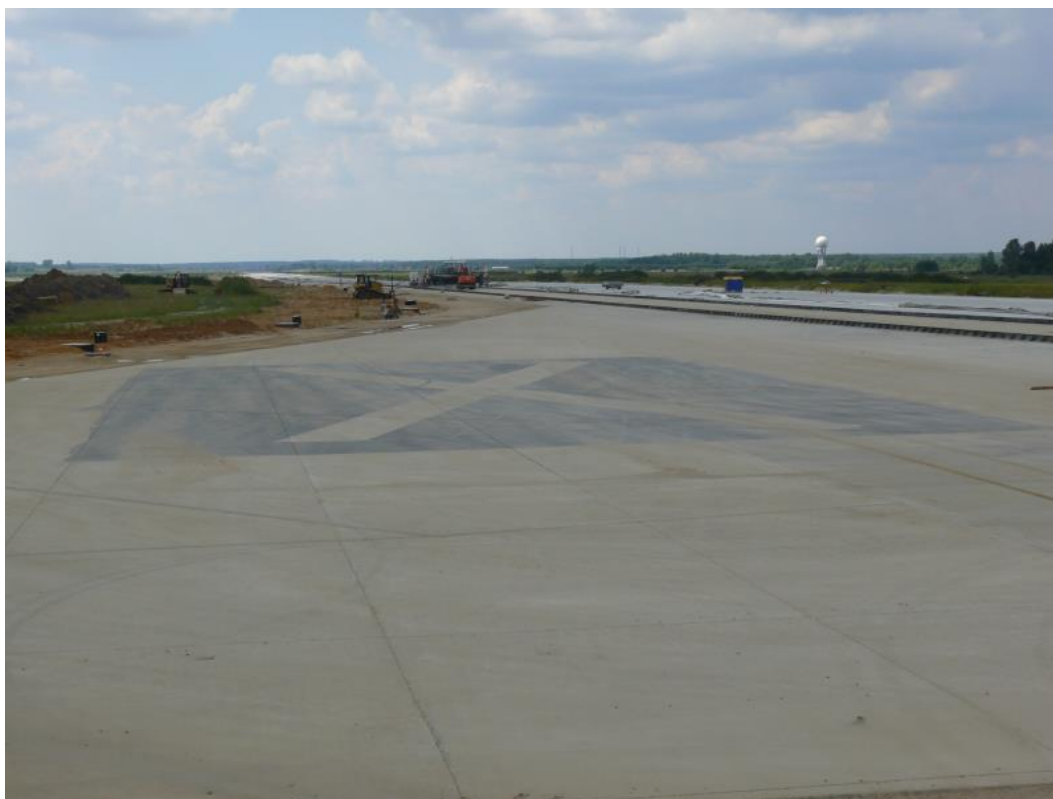
Fot. 3. Oznaczenie zamkniętej drogi startowej w budowie przy progu THR 27.
