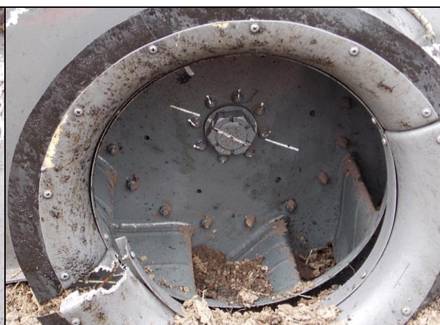
69 – Silnik – zbliżenie na wentylator chłodzenia.
