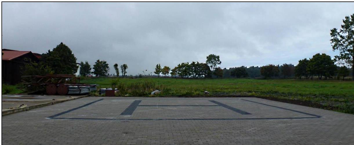
3 – Miejsce startu śmigłowca do lotu zakończonych wypadkiem – lądowisko prywatne w m.Borcz., widok w kierunku północnym.
