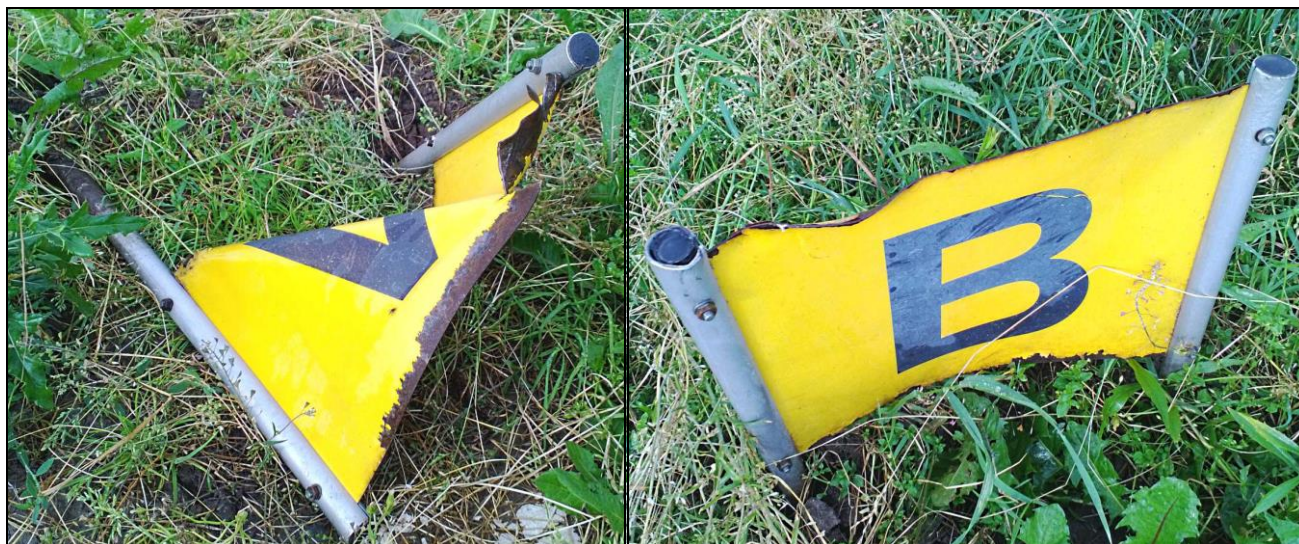
Uszkodzona tabliczki oznakowania drogi kołowania A – obok, dla porównania, nie uszkodzona tabliczka oznakowania drogi kołowania B.
